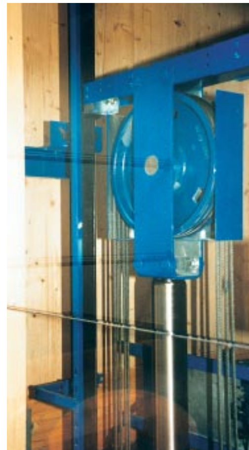
Foto unten: Seilumlenkung
