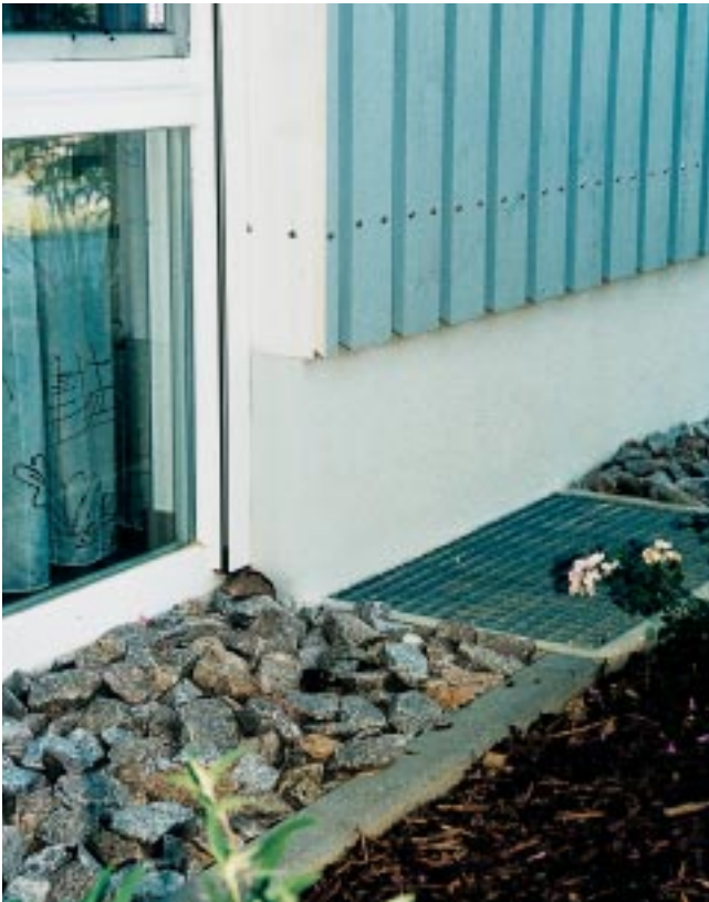
Detailaufnahme (oben): Sockel mit verputzter Faserzementplatte
