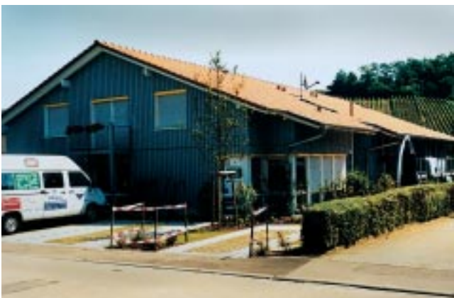
Hügelheim: die Straßenansicht von Südwesten.
