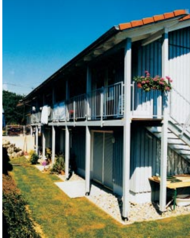
Die Südfront des Hauses mit den Fluchtbalkonen
