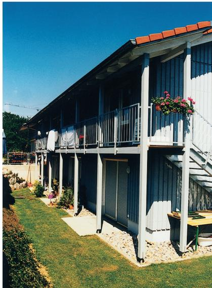
**Bild 14:** ..., die über den durchgehenden Fluchtbalkon aus dem EG und DG in den Garten führen.
