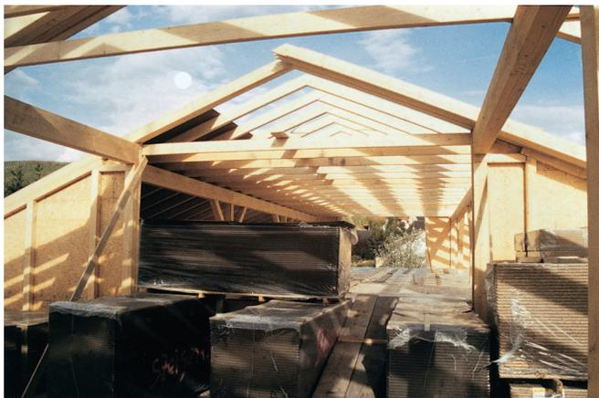
**Bild 4:** Das gesamte Gebäude ist ab dem betonierten Kellergeschoss als Holzskelett-Rahmenkonstruktion ausgeführt. Das Ständerwerk wurde vor Ort montiert.
