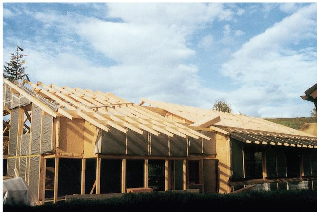
**Bild 5:** Die Tragkonstruktion wird mit 10 cm Dämmung "ausgefacht" und mit einer Winddichtungsfolie versehen, bevor die Dämmebene davor gehängt wird.
