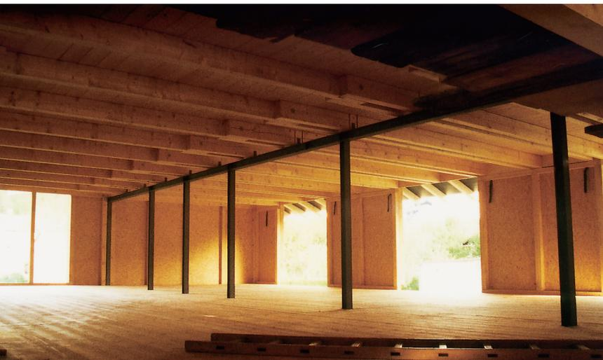
**Bild 6:** Stahlträger und -stützen dienen als Auflager für die Gerberträger, deren Gelenkpunkte als Zangen ausgeführt wurden.
