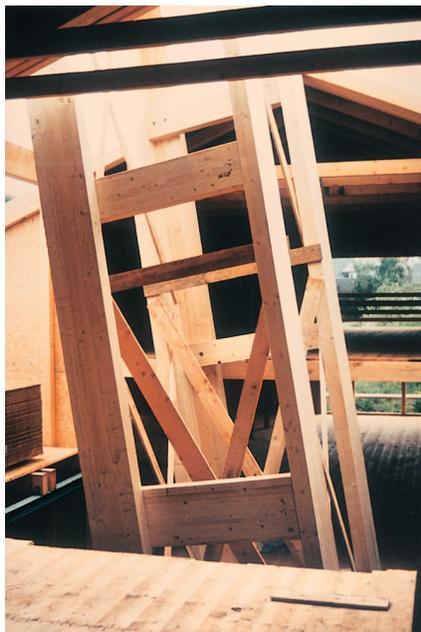
**Bild 9:** Das Schachtgerüst wird mit dem Kran ins „Treppenloch“ hineingestellt. Die selbsttragende BS-Holz-Konstruktion ist nicht mit der Holzkonstruktion des Gebäudes verbunden.
