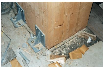
**Bild 10:** Der Aufzugsschacht ist über die Fußpunkte durch Stahlwinkel ausreichend mit dem Fundament verankert.
