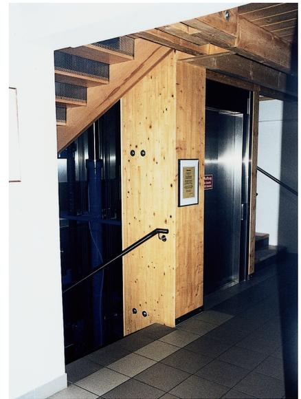
**Bild 15:** Das fertige, offene Treppenhaus mit sichtbarer Aufzugskabine. Die massiven Winkelstützen dienen als Türanschlag und dienen der Aussteifung.
