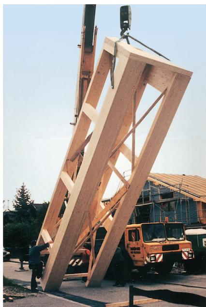
**Bild 7:** Der BS-Holz-Aufzugsschacht wurde werkseitig vormontiert und mit dem Kran als Ganzes eingehoben. Seitlich sind die Hilfsstreben zu erkennen.
